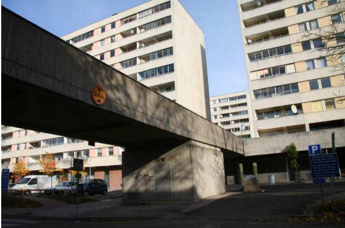
Gångbro i Tureberg. (Foto: Sollentuna kommun)
