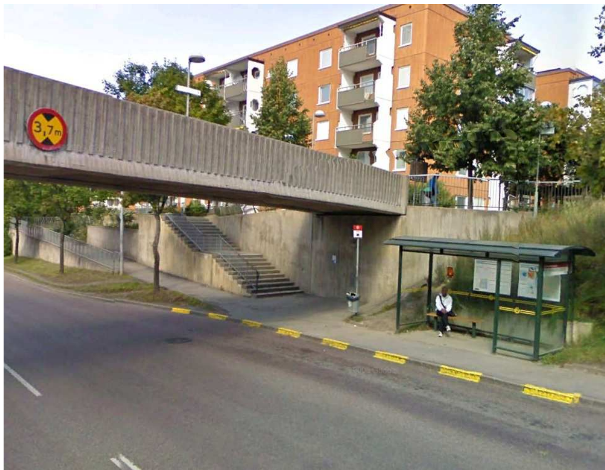
Figur 1 visar en, för Norgegatan, typisk busshållplats. Den är svår att nå för rörelsehindrade pga. branta backar eller trappor.
